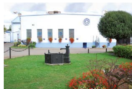
slévárna po rekonstrukci
