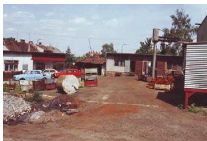
slévárna před rekonstrukcí
